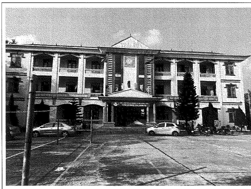
Hình 1.5. Hiện trạng trụ sở làm việc UBND xã Cẩm Lý
